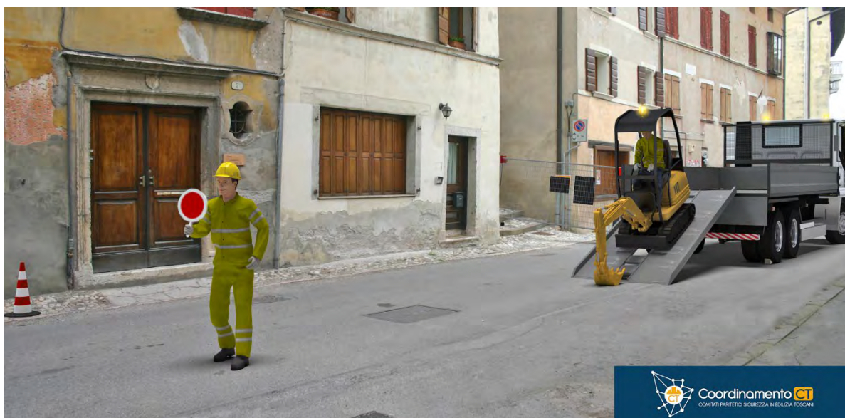
Figura 1 - Vista della zona interessata dai lavori con l'operatore che munito di paletta blocca il traffico veicolare
