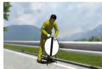
5 - dopo che viene posizionato il segnale via libera si apre la circolazione ai veicoli
