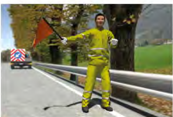
1 - un moviere con bandiera che segnala ai veicoli in transito la posa dei segnali
