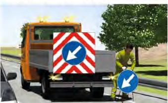
2 - gli operatori posizionano la segnaletica sulla banchina (sguardo rivolto al traffico)
