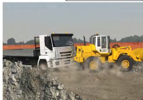
Incidente automobilistico tra mezzi operativi in cantiere.
