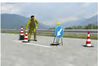
4 - gli operatori PROTETTI DAL MEZZO DI TRASPORTO E SEGNALATI DAL CAMION SCUDO posizionano la segnaletica sulla IN CARREGGIATA (sguardo SEMPRE rivolto al traffico)
