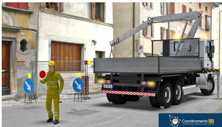
Figura 4 - vista della strada con l'autogrù in azione
